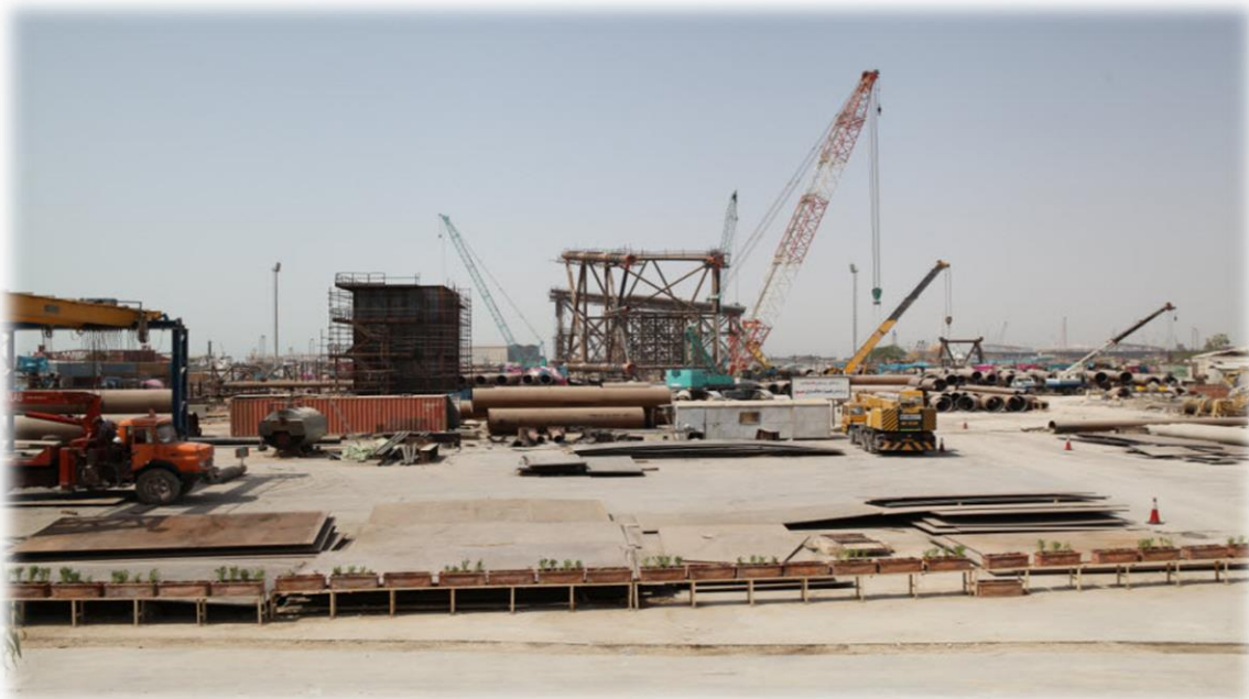
2. نمایی از کارخانه سکو سازی بوشهر
